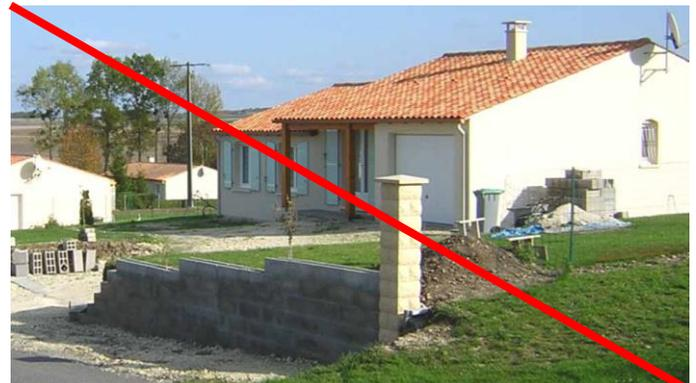
Mur en décrochement et pilier
